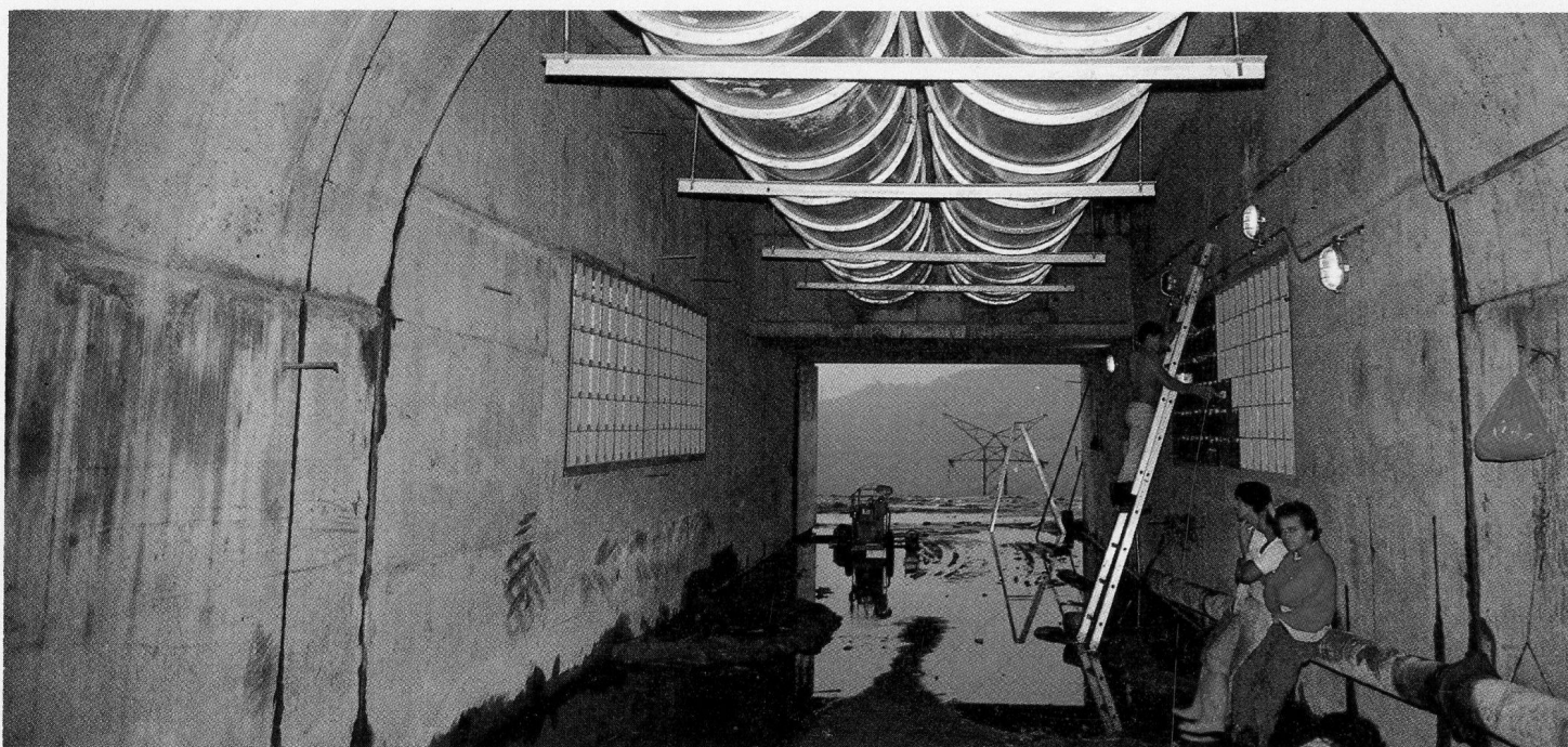
Acceso al túnel de presión; enfrente, vertedor de la presa de San Lorenzo.
